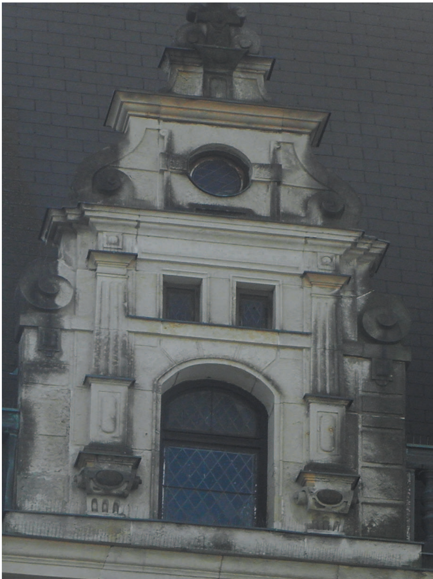
Typ štítu č. 7. Středové štíty strany k divadlu. Plocha vitrají jednoho štítu. 1,7 \text{ m}^2 \times 2 = 3,4 \text{ m}^2 .
