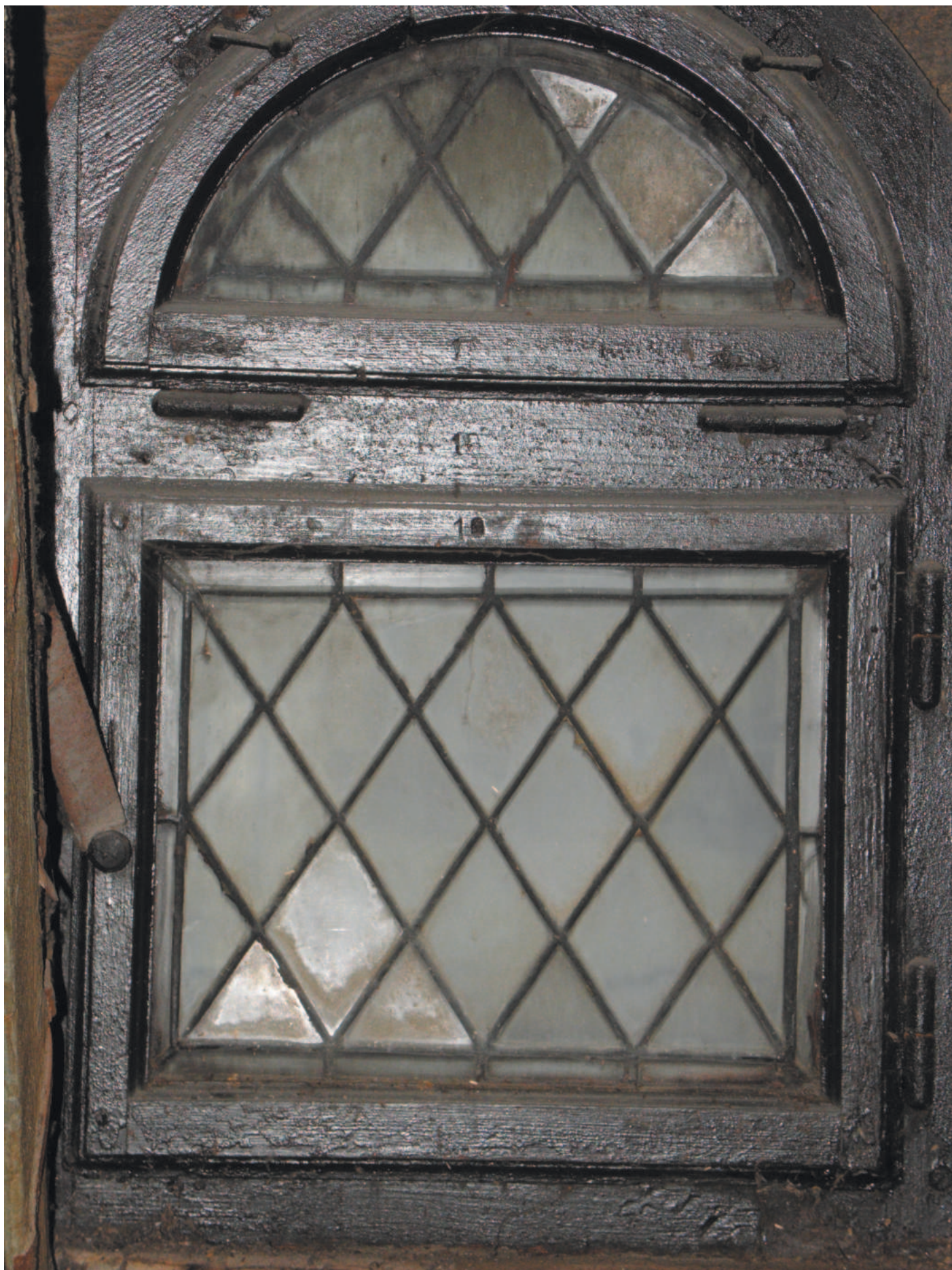
Typ okének směřujících do atrie radnice. Plocha vitraje jednoho okénka 0,19 \text{ m}^2 \times 10 = 1,9 \text{ m}^2 .
