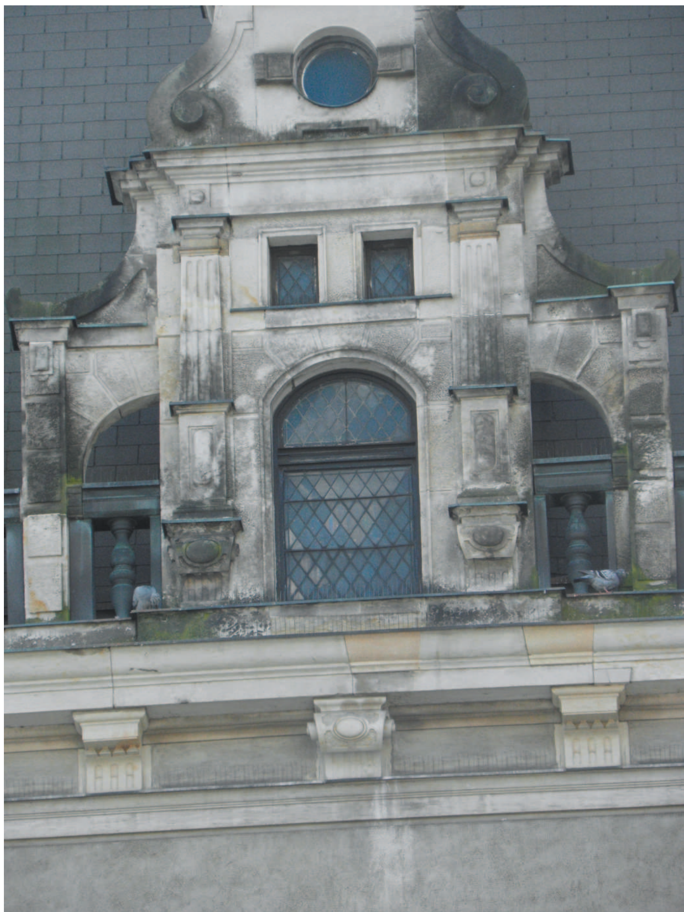
Typ štítu č. 6. Krajoiné štíty strany k divadlu. Plocha vitrají jednoho štítu. 1,7 \text{ m}^2 \times 2 = 3,4 \text{ m}^2 .
