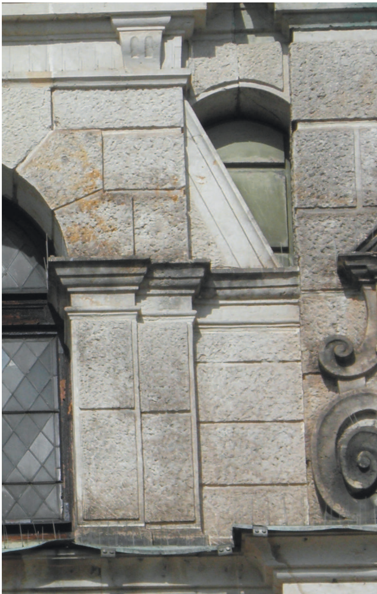
Zaslepené krajové otvory trojúhelníkového tvaru štítů přední strany radnice. Plocha vitraje do jednoho otvoru 0,2 \text{ m}^2 \times 12 \text{ ks} = 2,4 \text{ m}^2 .
