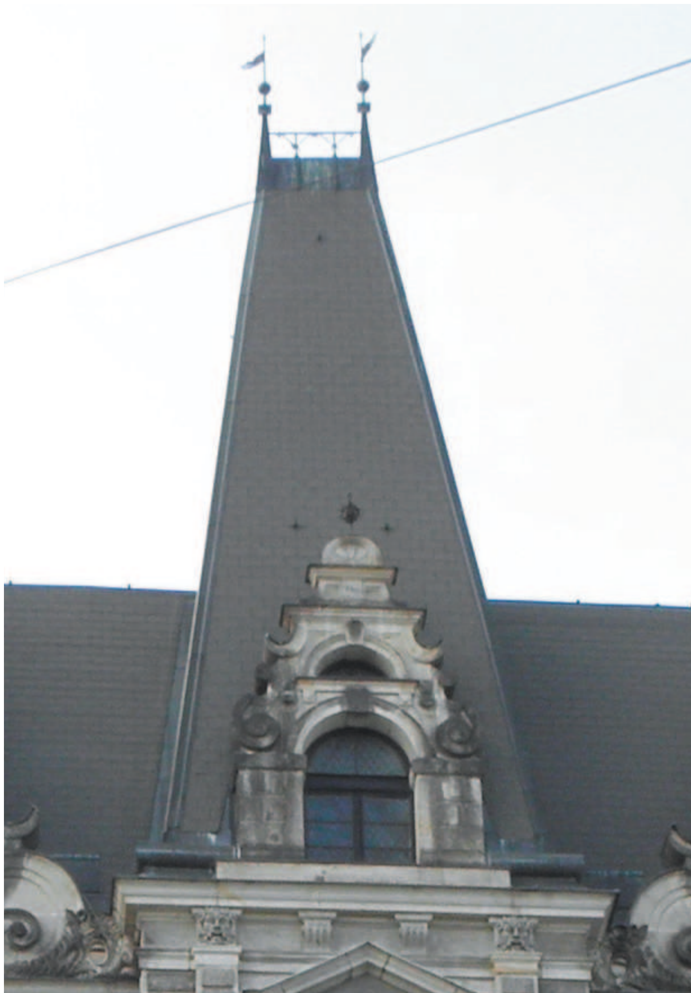
Typ štítu č. 4. Plocha vitrají jednoho štítu 1,7 \text{ m}^2 \times 2 = 3,4 \text{ m}^2 .
